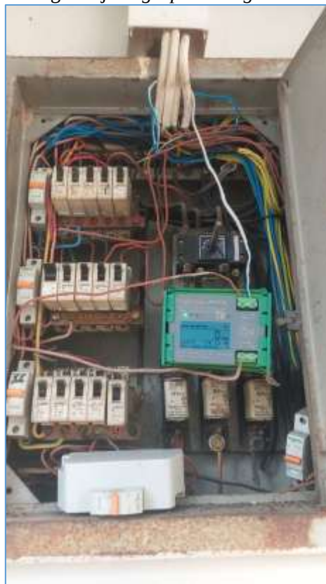
Gambar 8 Pemasangan perangkat IOT PM1611Q pada MCB
