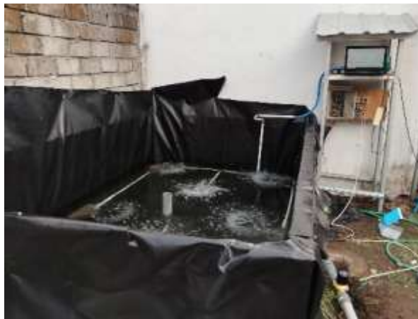
Gambar 8 Implementasi sistem monitoring dan otomatisasi pemulihan kualitas air pada kolam HDPE
